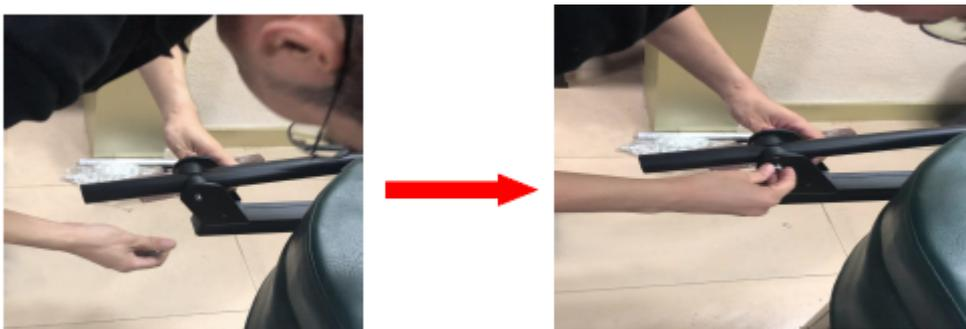
**Étape 7** : Vérifiez que le lève couverture est correctement positionné par rapport à l'arrière du spa
