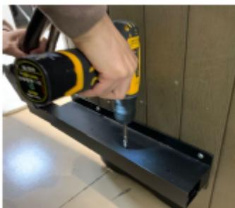
**Étape 9** : Fixez également le coupleur et les supports avec agrafes entre eux à l'aide des vis (12) et après avoir ajusté la largeur.
