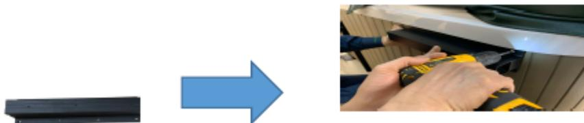
**Étape 2** : Associez les supports supérieur et inférieur du lève couverture (N°4) aux coupleurs (N°5) puis intégrez les dans les supports déjà montés en étape 1.
